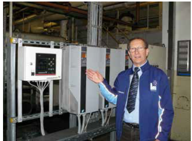
“只有新安装的控制技术能够识别机床何时不需要冷却润滑剂，因此泵在这个时候可以完全停止工作。”（大众汽车布伦瑞克工厂能源官 Paul-Gerhard Römermann）
